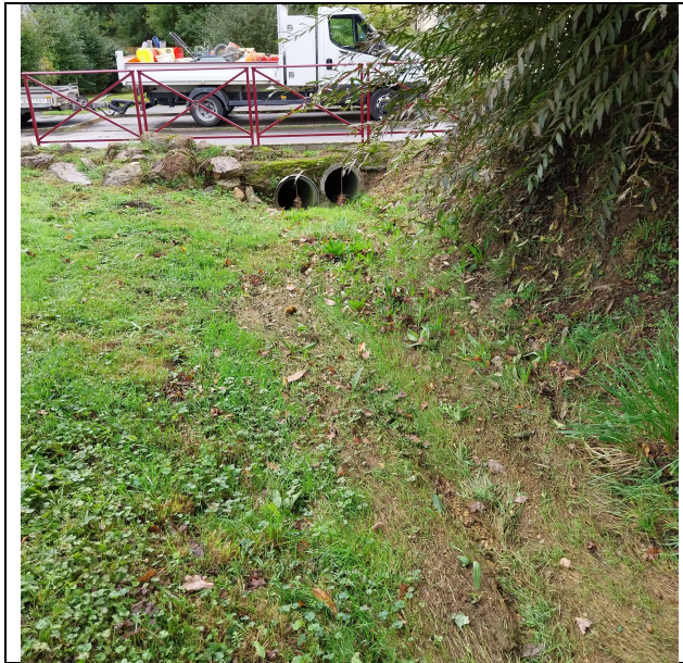
Vue amont du busage sous chaussée
